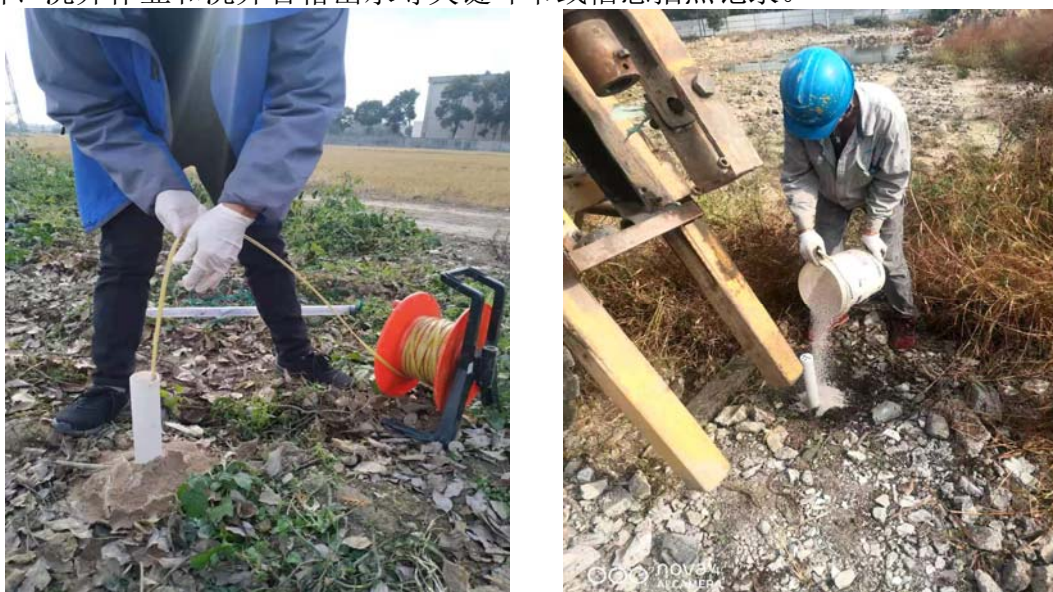
图 5.2-2 地下水建井照片
